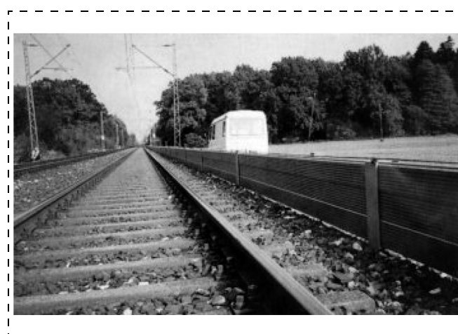
Рис. 4. Общий вид низкого шумозащитного экрана
