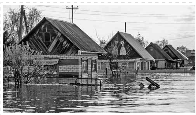
Рис. 2. Подтопленные дома частного сектора в городе Ишиме, Тюменская область, 2017 г. (источник: РИА "Новости")
