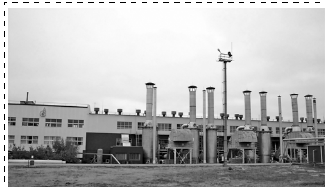
Рис. 1. Одно из линейно-производственных управлений магистрального транспорта газа ООО "Газпром трансгаз Самара"
