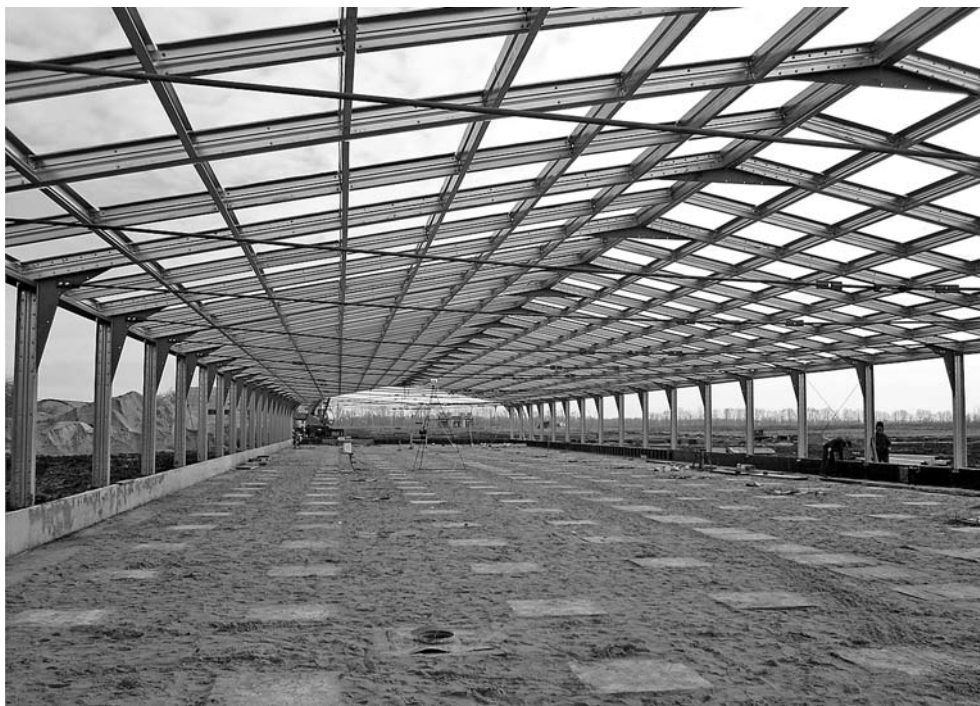
Рис. 2. Внешний вид песчаного основания днища навозосборника
