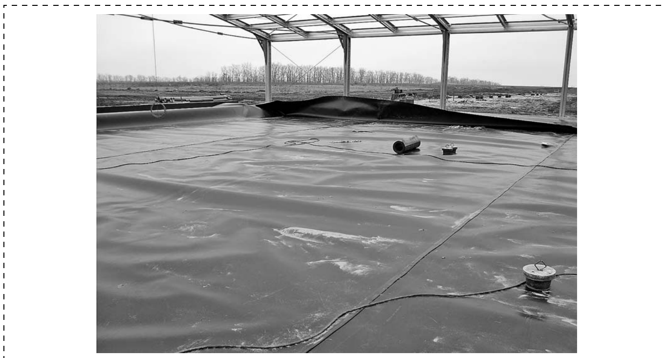
Рис. 1. Гидроизоляционный ковер на днище навозосборника
