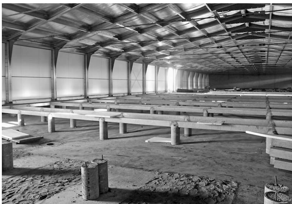
Рис. 3. Внешний вид гидроизоляционного ковра на днище навозосборника в процессе строительства
