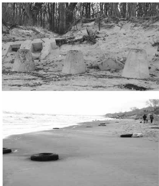
Рис. 1. Берегозащитные сооружения на морском побережье после шторма (г. Зеленоградск, Калининградская область)
