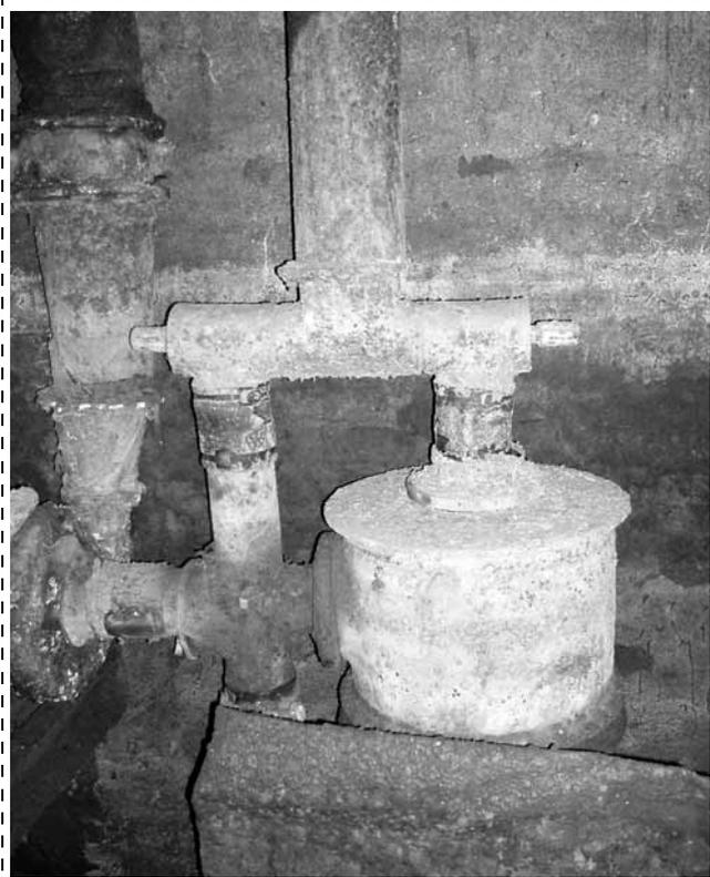
Рис. 3. Состояние фильтровентиляционного оборудования ЗС ГО
