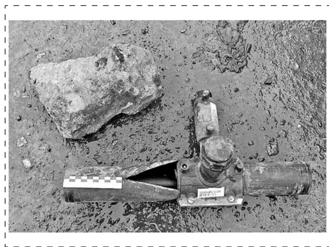
Рис. 7. Общий вид порыва газовой трубы (после ее демонтажа) и природного камня, который находился непосредственно на данной трубе
