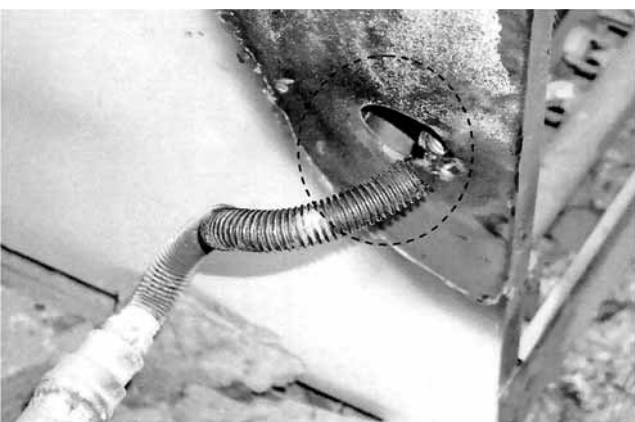
Рис. 6. Место прохода шланга через левую стенку котла
