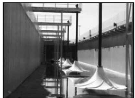
Рис. 2. Гиперболические мешалки
